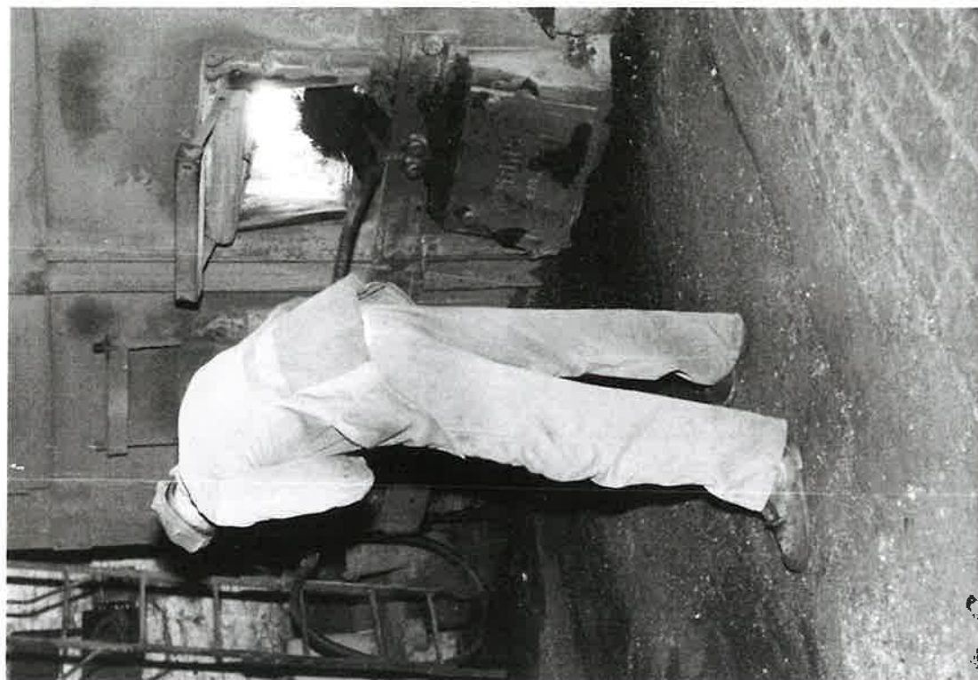
Louis Wilmet s'active à la chaufferie
