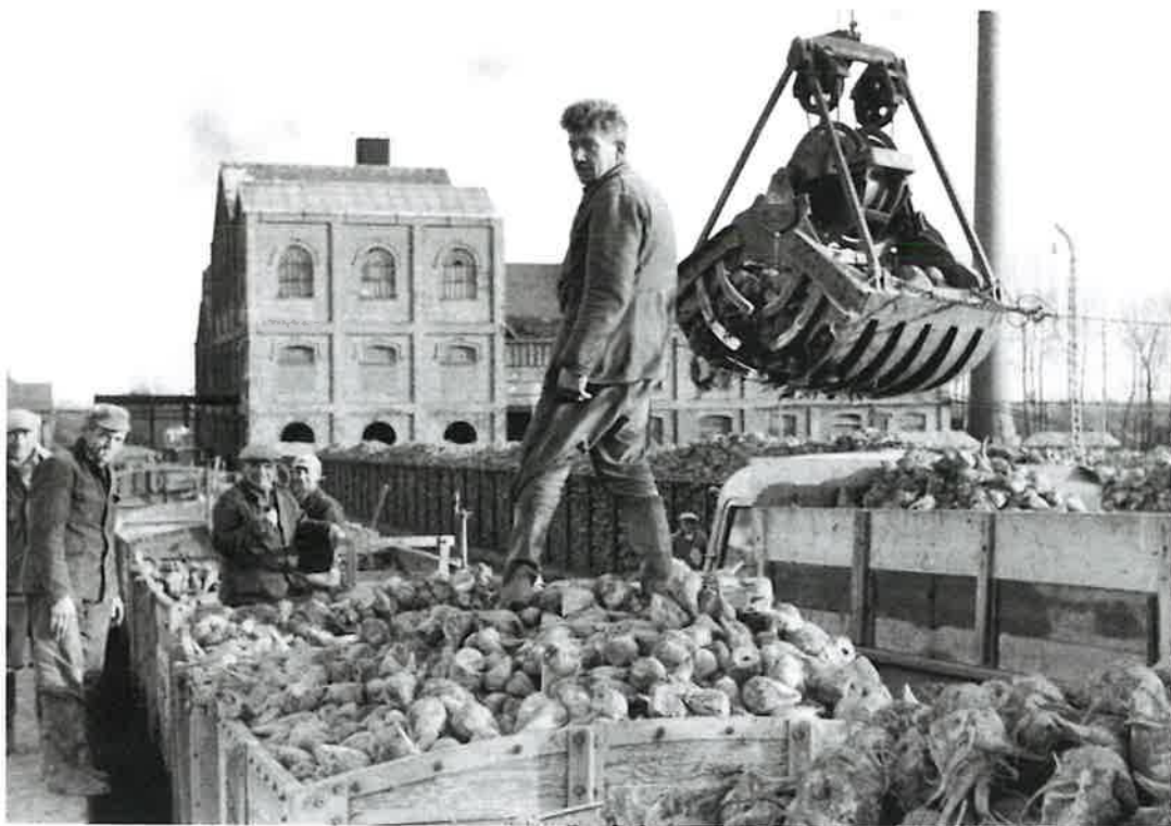
Déchargement à la grue
